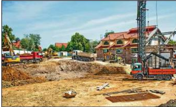
Schon von der Bundesstraße aus ist sichtbar: Auf dem Klinikgelände in Pfafferode wird gebaut – Technikräume und eine Großküche entstehen. Foto: Dantel Volkmann
