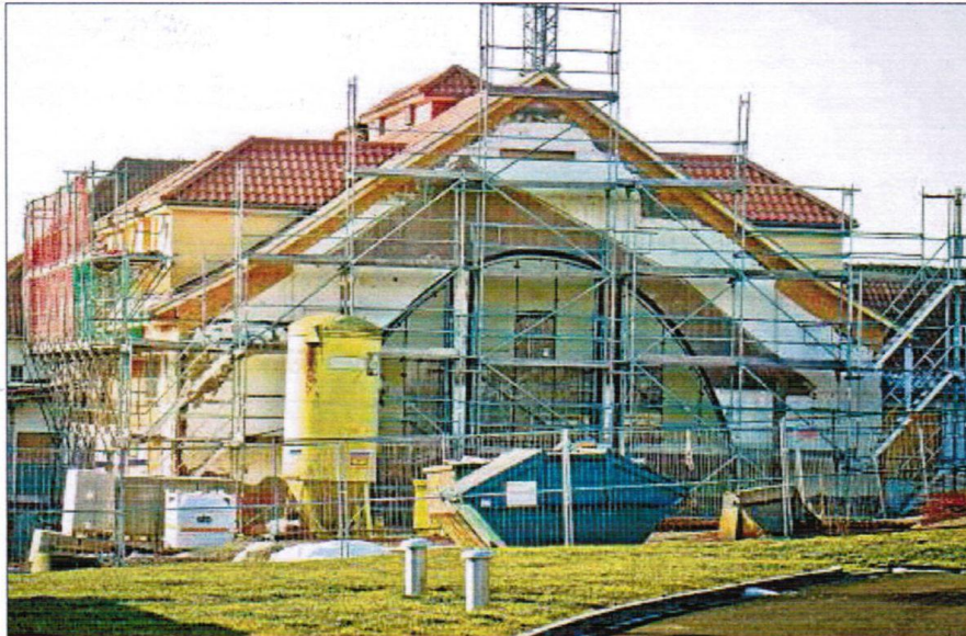
Aus dem einstigen Heizwerk entsteht ein Werkstatt- und Technikgebäude.
